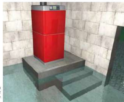
Protection d'un équipement de chauffage par surélévation.
