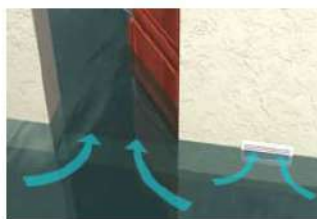
Situation initiale : l'eau pénètre par les portes et entrées d'air.
