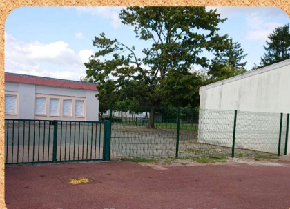
Pose de grillage rigide de 1.80m pour la sécurité des enfants
